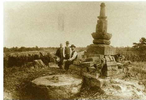
大正13年の七重塔心礎 心礎は直径1.8m、厚さ0.7m截頭円錐形で有ることが、この写真によってわかる。
